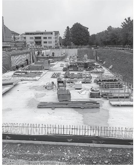
Zuerst wurde die gut von unten gedämmte Fundamentplatte erstellt. Diese dient als Bodenplatte für das Untergeschoss und zur ausgeglichenen Lastenübertragung in den Baugrund. Noch während der Erstellung der Fundamentplatte der dritten Etappe konnten bereits die ersten Aussenwände im Untergeschoss der ersten Etappe ausgeschalt werden.
