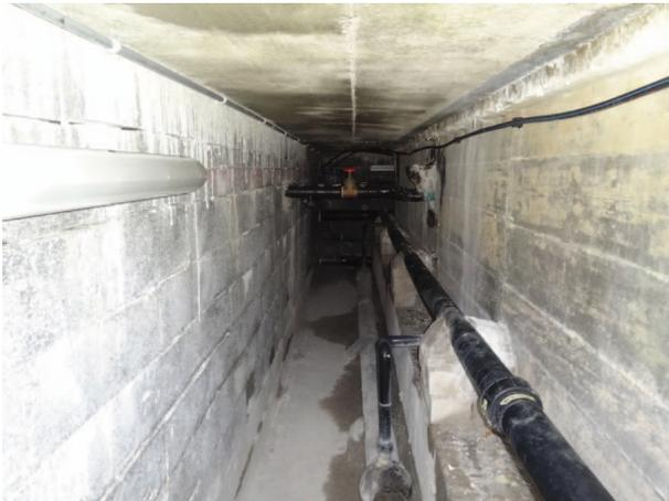
Bestehender Kriechgang mit Becken-Verbindungsleitungen aus Polyethylen
