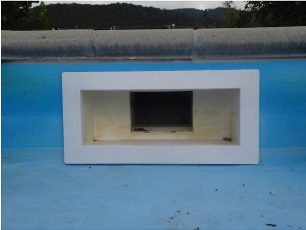
Bestehender Beckenkopf aus Beton-Elementen, mit Folie verkleidete Beckenwand und Skimmer.
